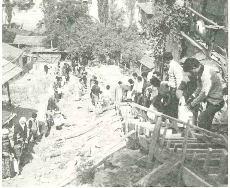
Zafertepe'nin farklı bölgelerinde dört adet merdivenin imece yöntemiyle yapım çalışmaları
